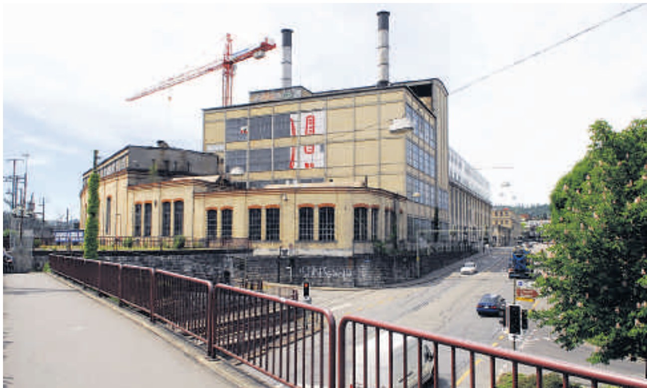
Ein Neubau im Altbau ist für das Kesselhaus geplant, damit der Zeuge der Industriegeschichte erhalten bleibt. Bild: Marc Dahinden
